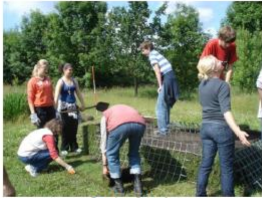
Bau eines Grassofas
